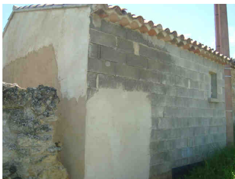
Le chantier en cours (réalisation des enduits).
