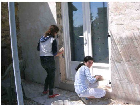
Le chantier en cours (réalisation des encadrements).
