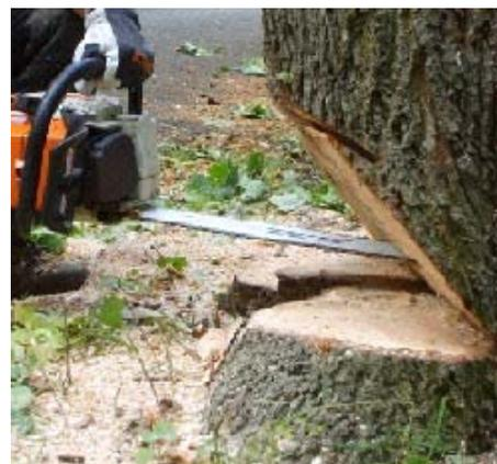
Insérez la partie inférieure du guide en perçant derrière la charnière (préservez impérativement la charnière)
